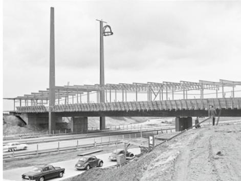
**104 x 38 Meter.** Das Raststättengebäude entwarfen die Architekten Paul Wolters und Manfred Bock. Die Brückenkonstruktion sollte ein verbindendes Element der durch die Autobahn getrennten Landschaftshälften sein.
