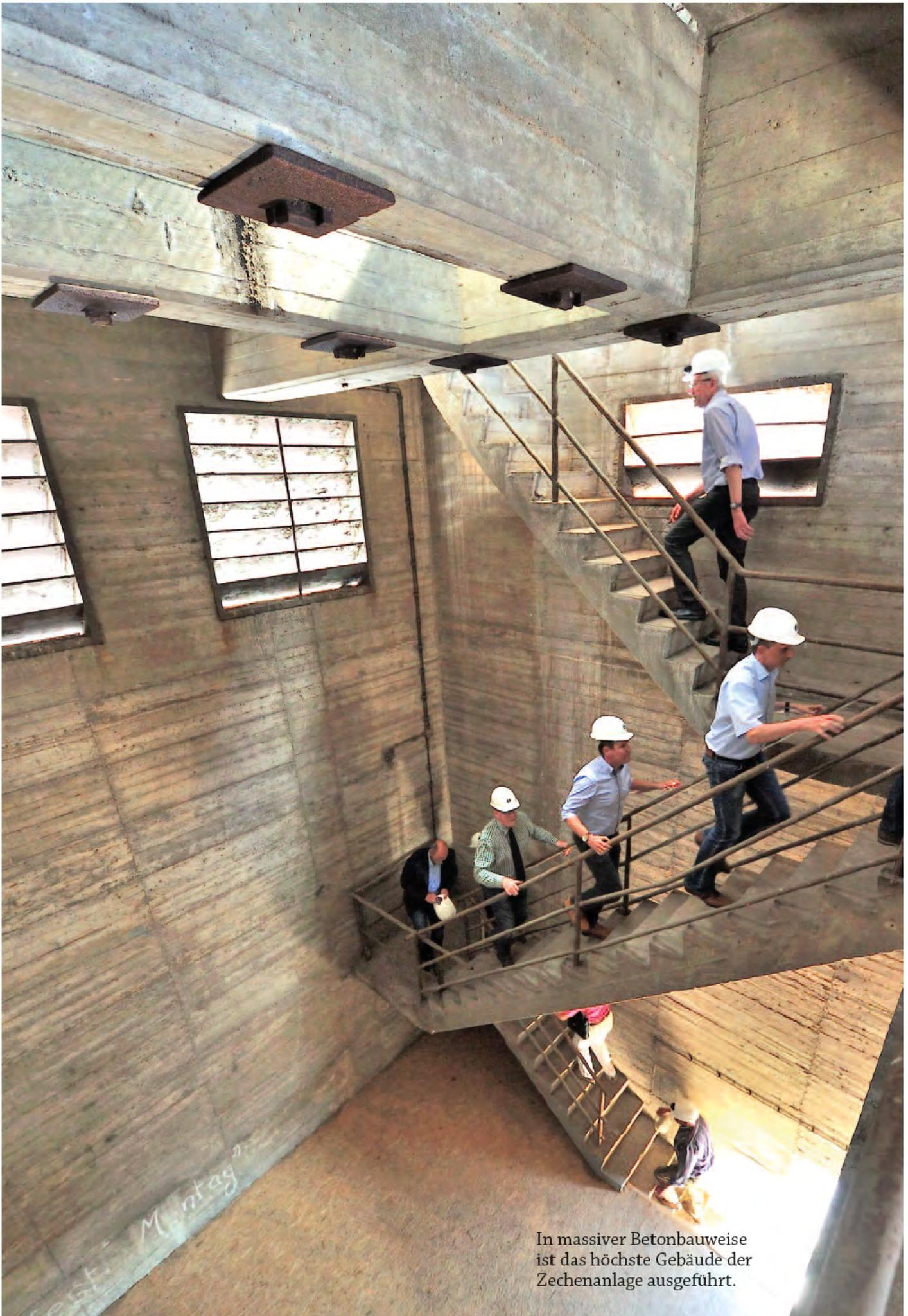
In massiver Betonbauweise ist das höchste Gebäude der Zechenanlage ausgeführt.
